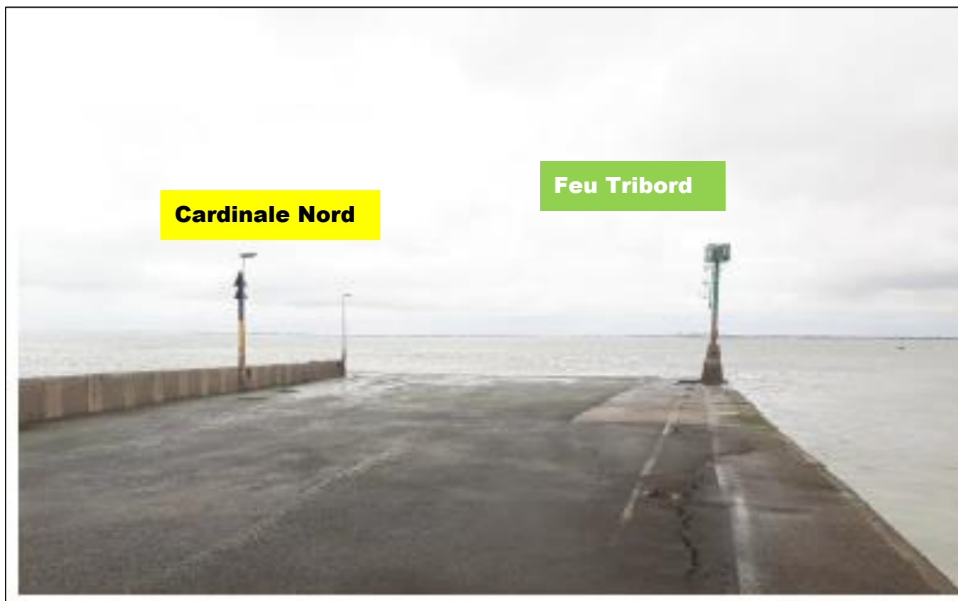
Figure 15 : Balisage actuel de la jetée de La Fumée à Fouras : photographie.
